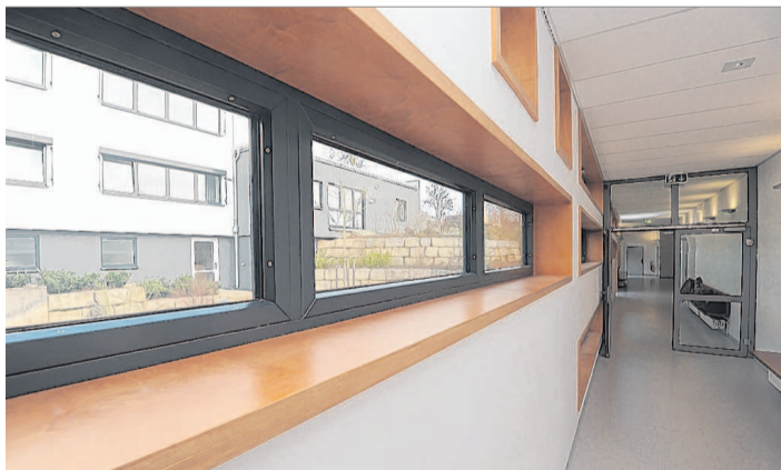
Fassadendämmung architektonisch anspruchsvoll umgesetzt.
