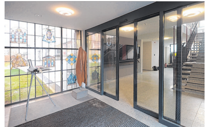
Am Eingang wurde ein Windfang installiert.
