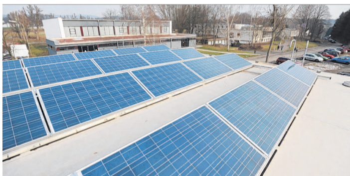
Fotovoltaikanlagen auf Haupthaus (28 kW p ) und Wohnheim (12 kW p ) tragen zur Deckung des Strombedarfs am Laubach-Kolleg bei.
