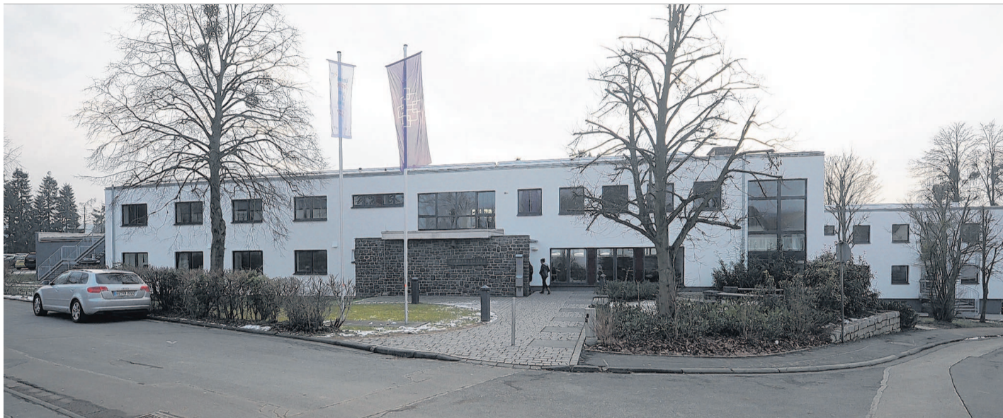
Das Haupthaus des Laubach-Kollegs ist energetisch saniert worden.
